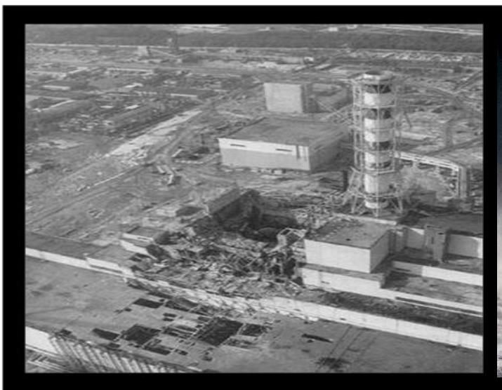
Εργοστάσιο παραγωγής πυρηνικής ενέργειας
